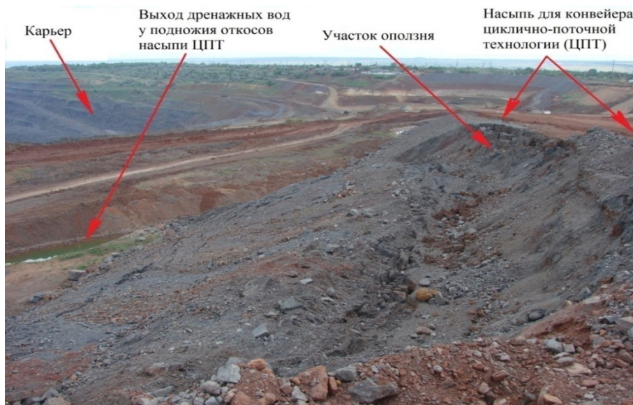
Рисунок 2 – Оползень насыпи ЦПТ
