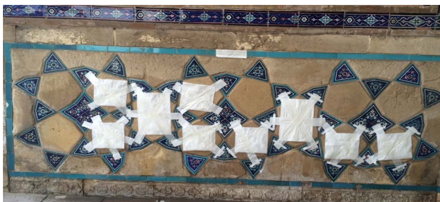
Сурет 2 – Тұзды қатпарларды компресс әдісімен жою
